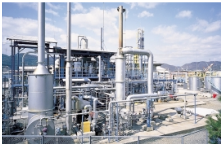
廃プラスチック油化プラント
