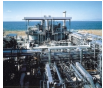
下水汚泥焼却溶融炉
