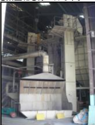
尼崎(異形管砂再生)
