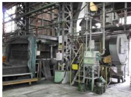
尼崎(ロール砂再生)
