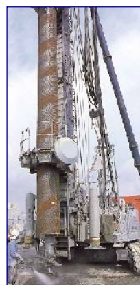
ガンテツパイル
