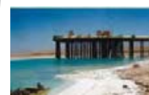
● “死海”取水設備 [ヨルダン]
