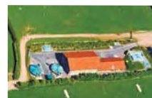
● 下水処理場 [イギリス]
