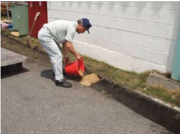
砂を散布し、塗料を吸着
