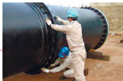
本製品はUAEで、口径1,600mmの鉄管（写真）による総延長47kmもの大規模パイプラインに採用されました。
