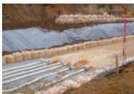
二次災害防止のための移動式ポンプによる排水作業
