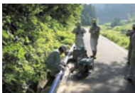
断水地域への水道管の緊急敷設
