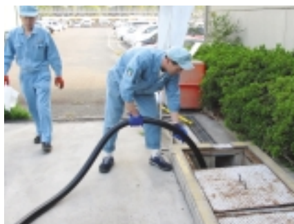
油水分離槽に流入した廃液を、バキューム車で吸い取る
