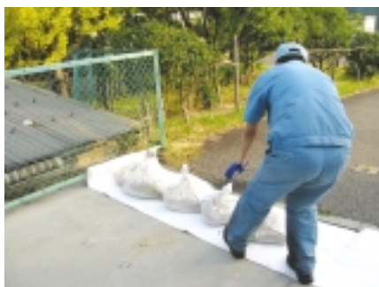
廃液が側溝、会所に流入しないようオイルマット、土のうで防止する
