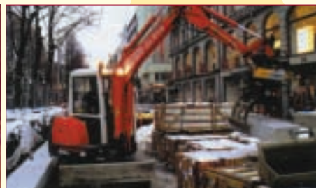
新型エンジンを搭載したミニバックホーによる建設現場
