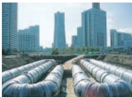
ダクタイル鑄鉄製貯水槽(耐震用・緊急用)
