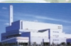
スーパー発電付ごみ焼却プラント
