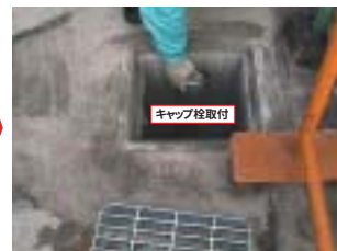
①キャブ栓会所で給油開始前にキャブ栓を取付ける ②洩れた油は油水分離槽で回収される
