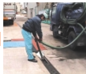
水洗いと同時にバキューム車にて側溝に溜まった薬液を吸入し6T/日廃水処理施設原水槽に投入する。
