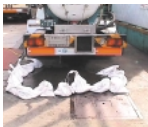
会所の周囲に土のうを積み流入防止及び拡散防止の処置。
