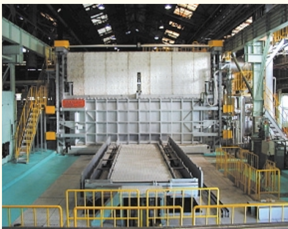
パイプ搬入側
