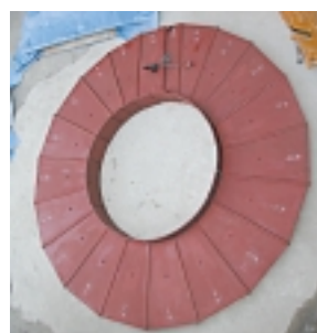
遮水壁の陸組状況
