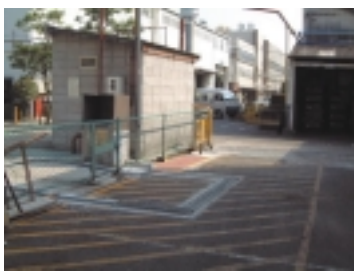
タンクローリーの重油受入作業時の重油洩れ対策(堺製造所) 油回収側構設置
