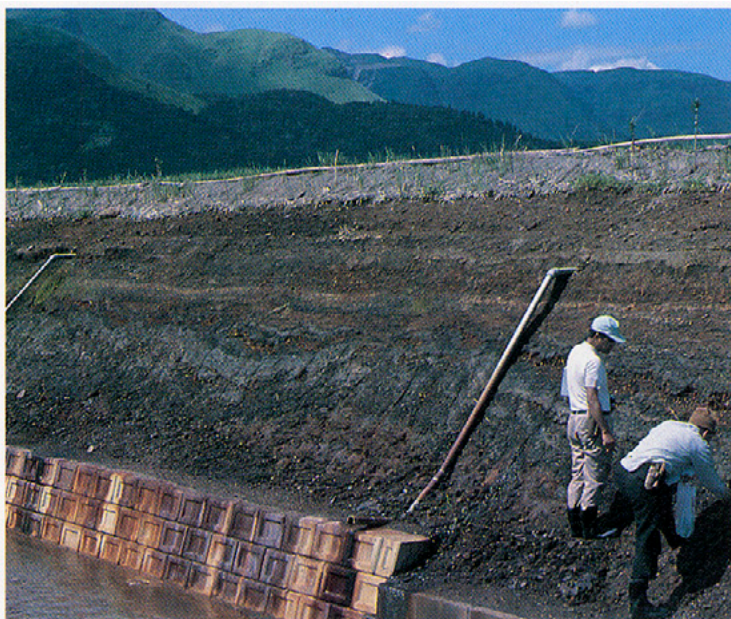
写真4・1 - 基盤整備圃場の中央排水溝。背後の山脈は外輪山
