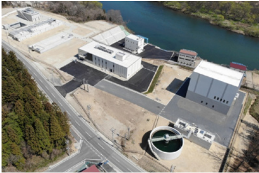
新北上浄水場全景
