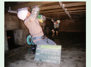
下部圧力室の点検
