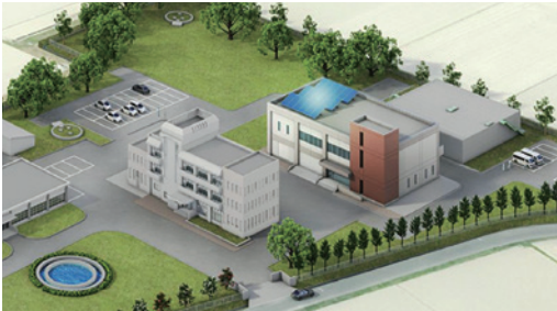
坂根浄水場完成イメージ
