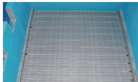
④ 有孔ブロック据付完了
