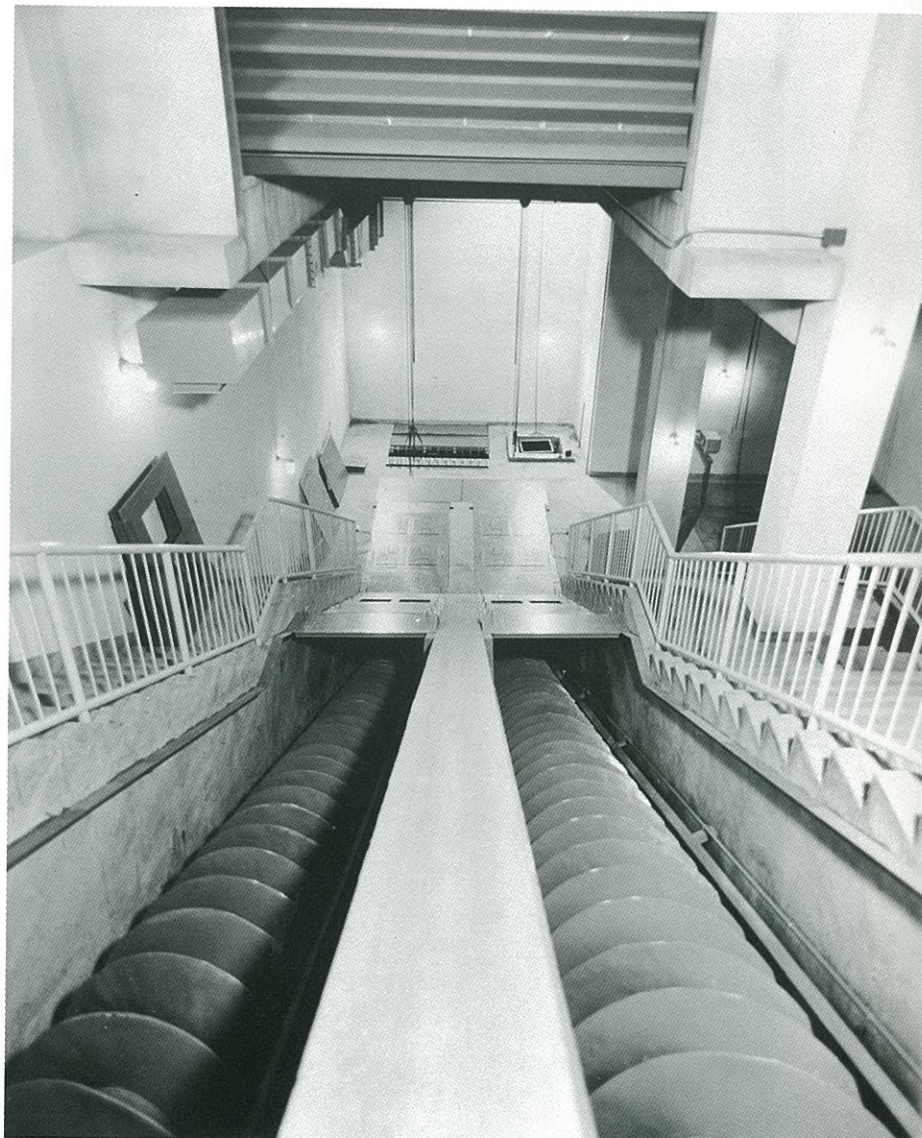
●駆動側よりみたスクリーンプンプ本体
