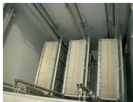
液中膜据付状況
