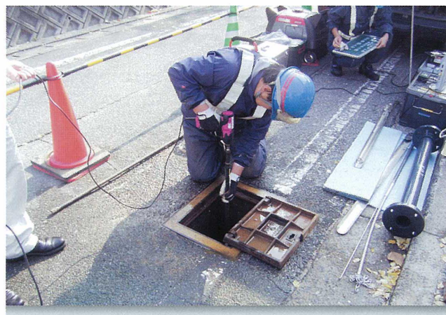
挿入前錆落し
