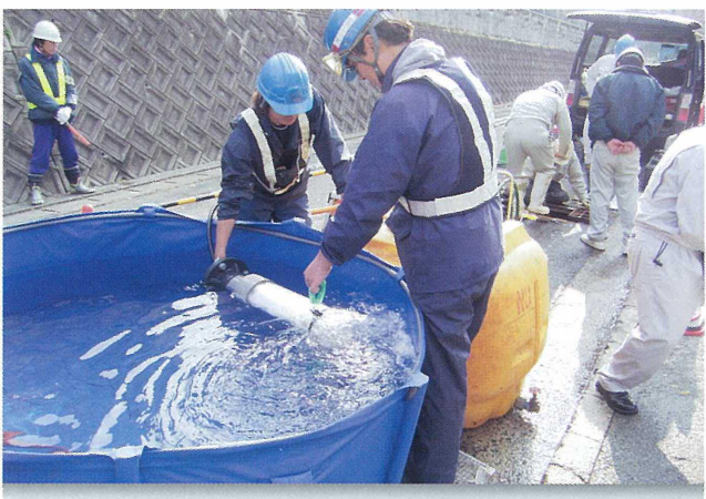
試運転の状況
