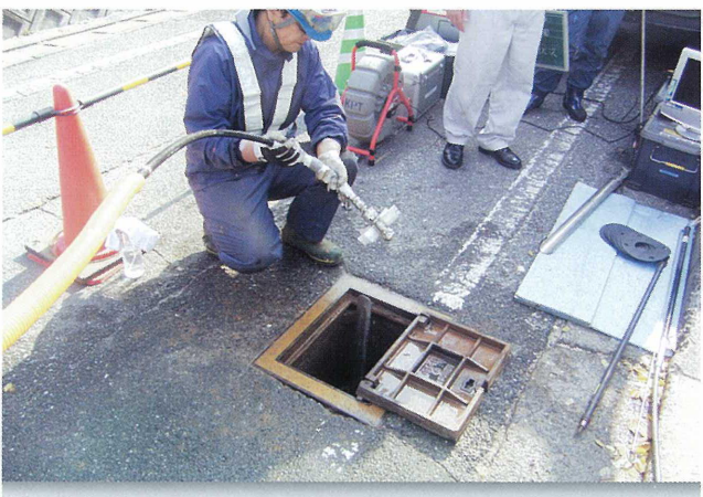
洗浄ヘッドの挿入
