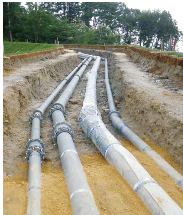
GENEX (GX形) 呼び径150、250、NS形 呼び径300、GX 形呼び径150
