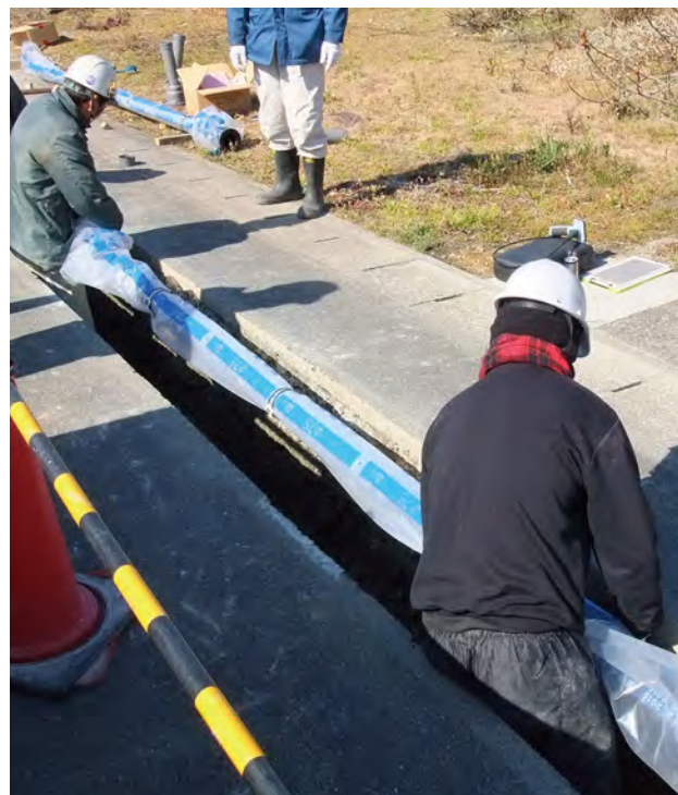
NECS (NS形E種管) 呼び径75
