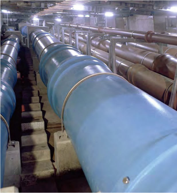
S形(写真中央) 呼び径1200
