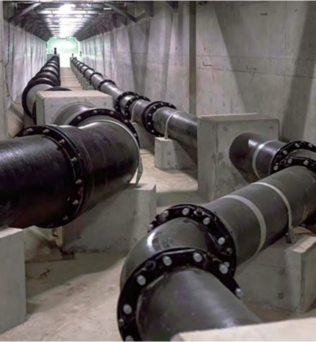
[左]S形 呼び径600 [右]SII形 呼び径400
