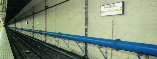
鉄道(湧水の排水管)
