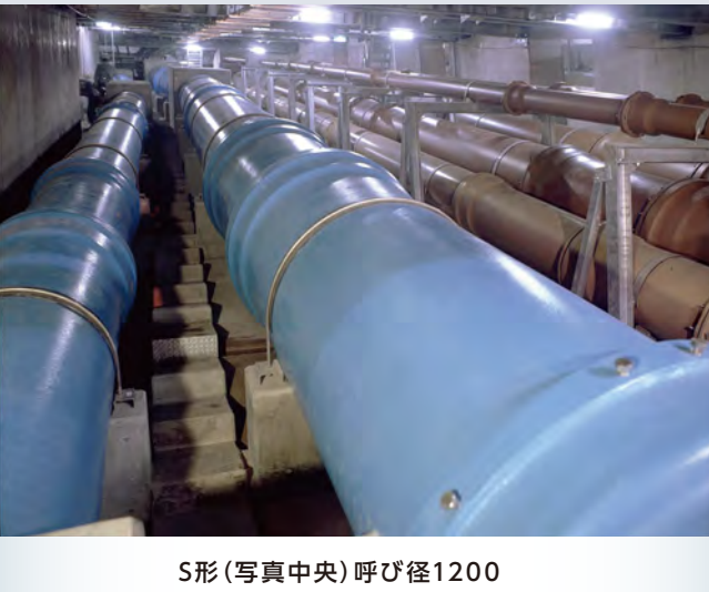
S形 (写真中央) 呼び径1200
