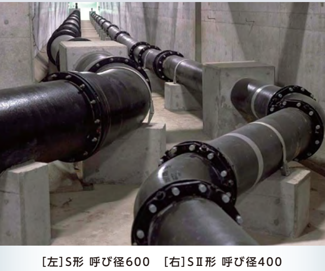
[左] S形 呼び径600 [右] SⅡ形 呼び径400
