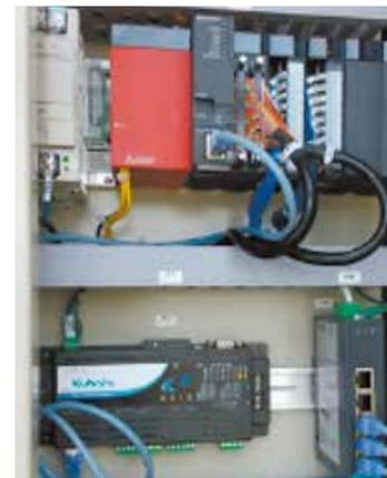
PLC 通信ユニットの設置例 (上段は PLC)
