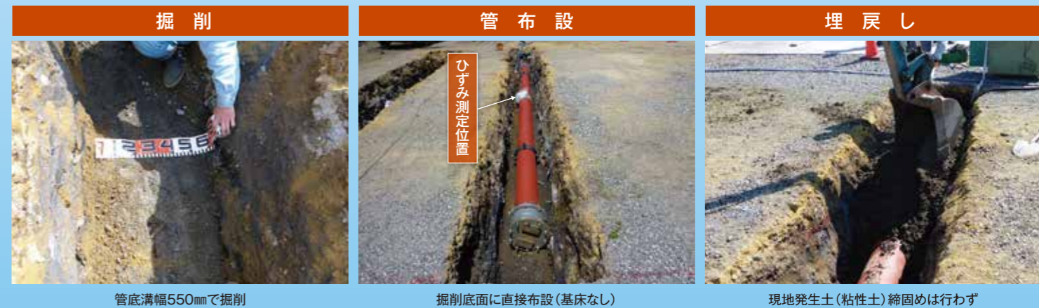
管底溝幅550mmで掘削
