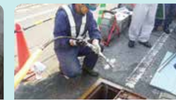
管内洗浄技術 (TS工法)
