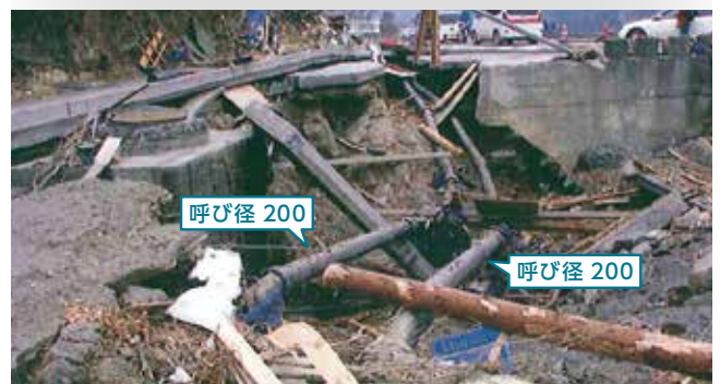
道路崩壊(東日本大震災、宮古市)
