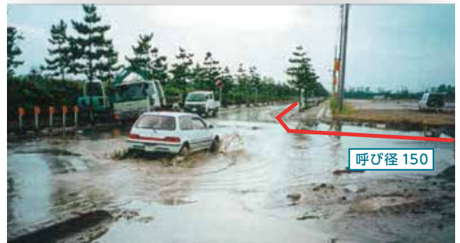
液状化(鳥取西部地震、鳥取市)
