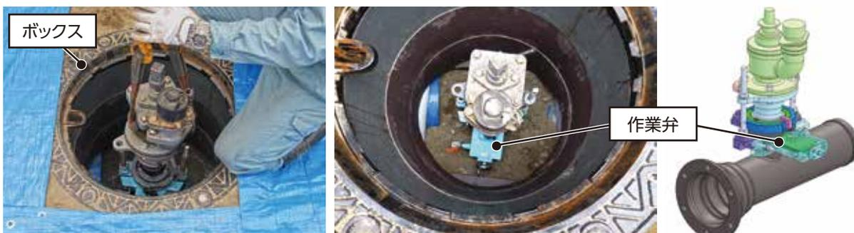
[注記] 掘削せずに作業を行うためには、内径600以上のボックスとする必要があります。
