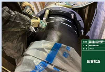
施工情報システムⅡを使用した呼び径500の配管状況
