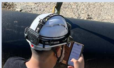
施工情報システムⅡを使用した呼び径500の配管状況
