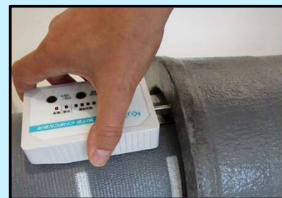
「サイトチェッカー」を用いた ゴム輪位置確認作業の様子
