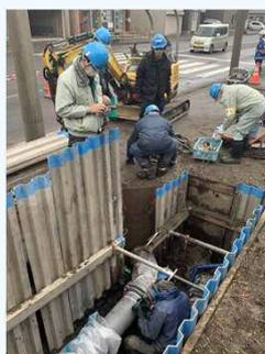
伊達市建設部上下水道課様が発注しました「西通り線外配水管布設工事(GX形ダクタイトイル鉄管呼び径300×70m)」の水道工事現場において、施工情報システムを試験的に利用しました。
