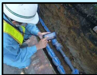
〈 施工現場での様子 〉
