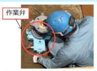
作業弁用開口部から 作業弁を取り付けることで、 不断水交換を行うことが可能
