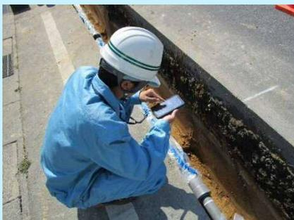
また、今回ご紹介した「施工情報システム」を活用して施工品質をよりいっそう向上させるために新たな技術開発にも取り組んでいます。現在、開発中の「サイトチェッカー」は、直管継手のゴム輪位置を容易に測定することが可能で、測定結果を「施工情報システム」にデータ送信することができます。測定値をメモ書きする必要がなく、誤記を防止することができるようになりました。また、専用の治具にセットしたスマートフォンで撮影した写真より画像解析を行い、継手の屈曲角度を判定するアプリケーションも開発中です。
