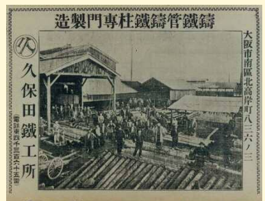
【明治38年頃の弊社鉄管出荷場】
