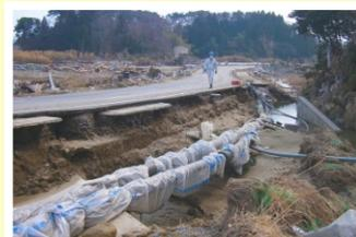
↑ 津波の被害にも耐えた水道管
