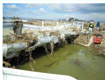
津波にも耐えた橋梁添架管
