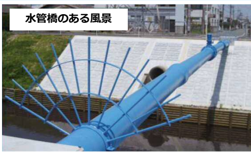
呼び径350×22.23mダクティル鉄管製水管橋
