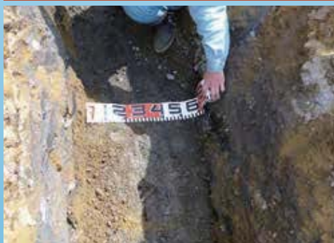
管底溝幅550mmで掘削
