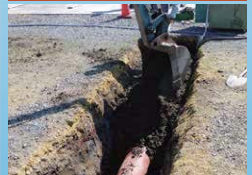
現地発生土(粘性土)締固めは行わず
