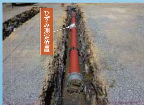
掘削底面に直接布設(基床なし)
