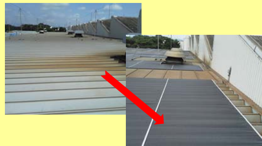
(折板屋根への遮熱シート取付)
