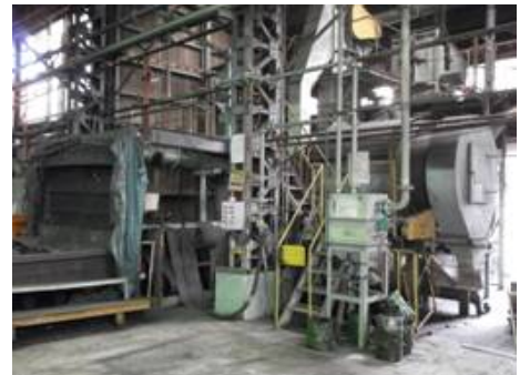
尼崎(ロール砂再生)
