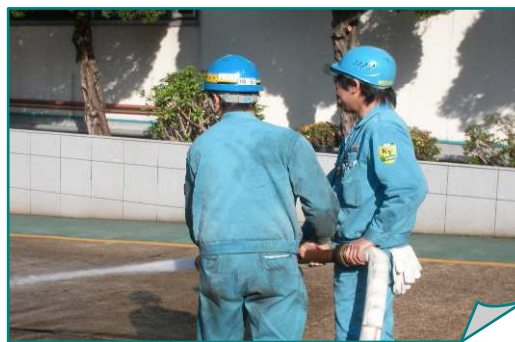
エンジンポンプ車による放水テスト
