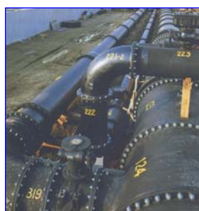
異形管を用いた 配管風景
