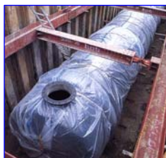
耐震・緊急用貯水槽
