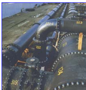
異形管を用いた 配管風景
