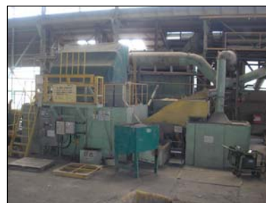
尼崎(ロール砂再生)
