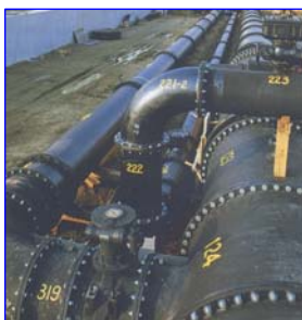
異形管を用いた 配管風景
