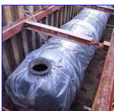
耐震・緊急用貯水槽
