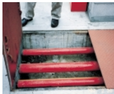
埋設送油配管の改善例(堺製造所)
