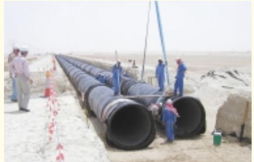
口径1600mm、長さ世界最長9mの直管が接合され、地平線の彼方まで続いていく。
