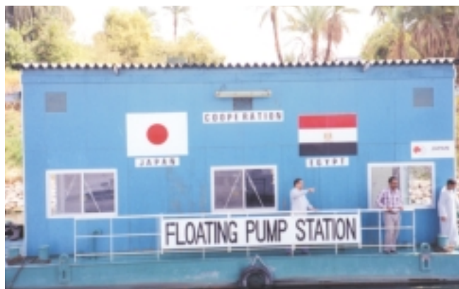
フローティングポンプステーション
