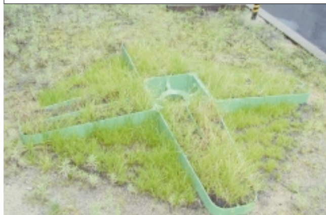
施工・植栽例
