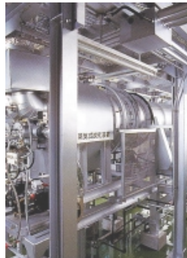
奈良県 山辺環境衛生組合 山辺衛生センター
