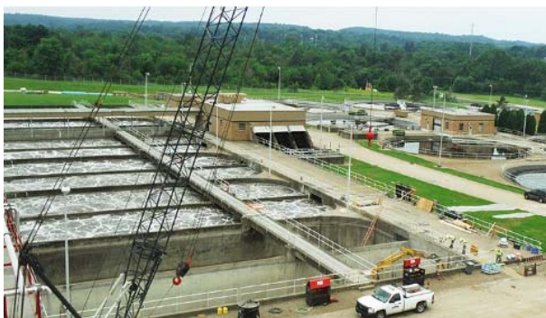
上下水 処理設備
